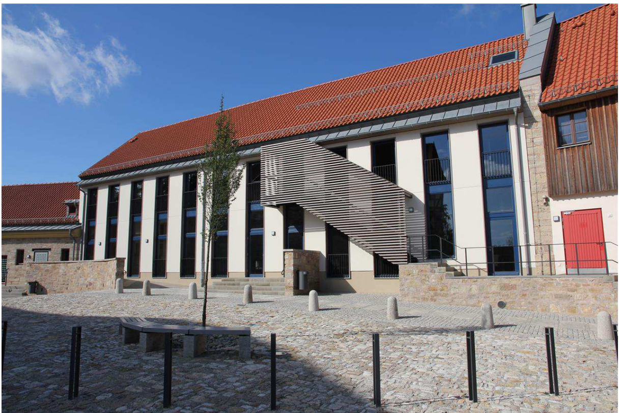
Sanierung Burghof und Terrasse Burg Scharfenstein im Jahr 2010
