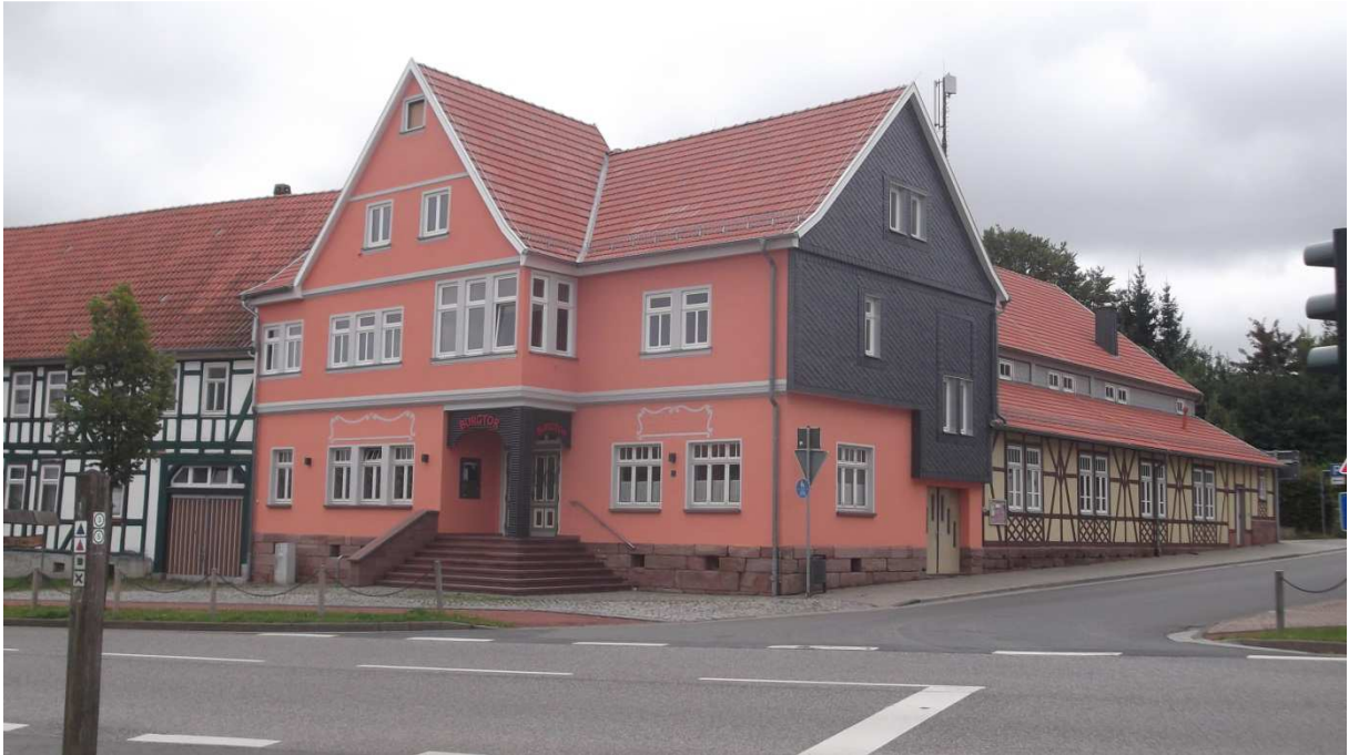
Sanierung Gaststätte/Gemeindesaal „Burgtor“ im Jahr 2014
