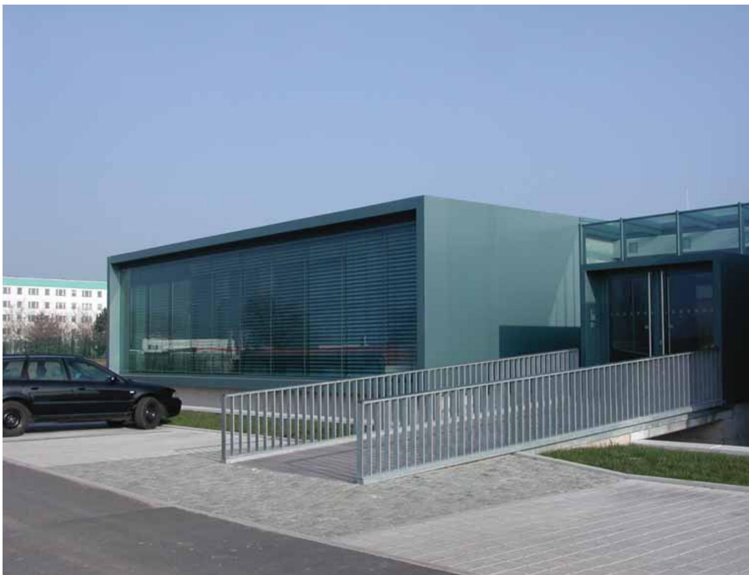
Architekturbeispiel: Verwaltungsgebäude des Trinkwasser-Zweckverbandes in Leinefelde
