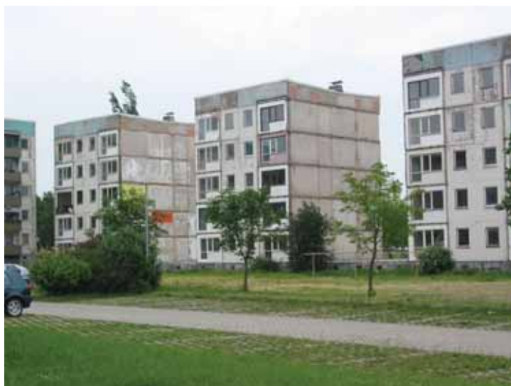
Die zukünftigen Stadt villen finden viel Interesse; der erste Bauabschnitt ist schon vor Beginn der eigentlichen Modernisierung weitgehend vermietet.
