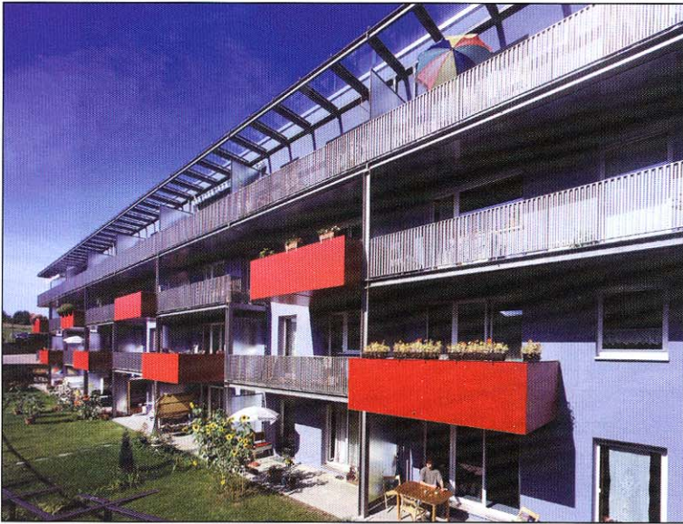
Abb 2: Rückbau eines sechsgeschossigen Plattenbaus auf vier Stockwerke
