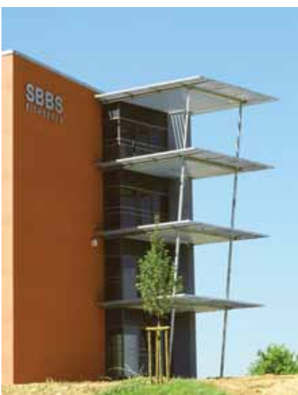
Richtungsweisender Umbau der ehemaligen Polytechnischen Schule zum Berufsbildenden Zentrum
