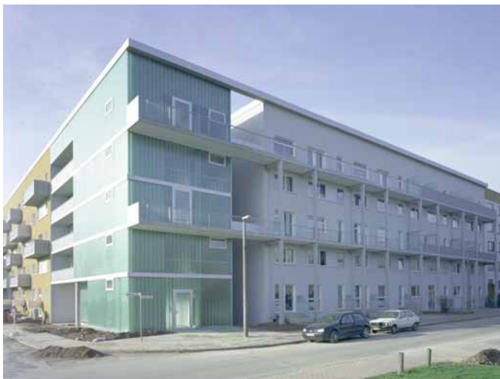
Reparatur des Stadtraums und neue Nutzungsqualität: die Eckschließung schafft zusätzlichen Wohnraum und erschließt über die Laubengänge die Wohnungen in den Obergeschossen barrierefrei.
