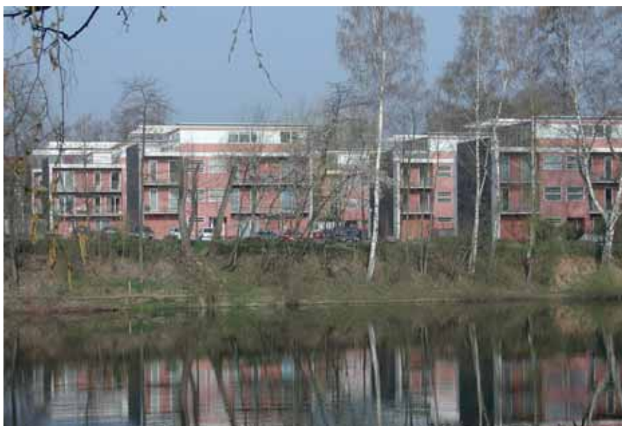
Die erste Konversion in Leinefelde: Hochwertiges Wohnen in zentraler Lage am Standort einer ehemaligen KITA als Ergebnis eines Architektenwettbewerbs.
