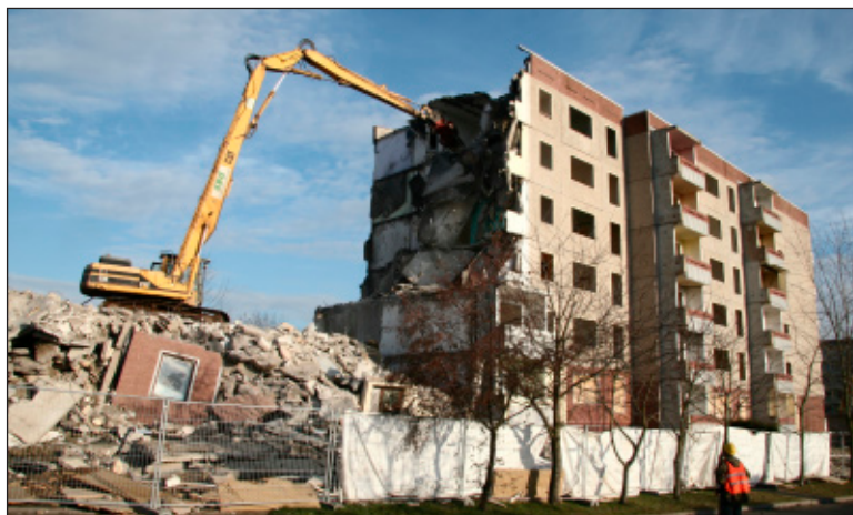
Hier ist der Rückbau der Wohnblöcke in der Herderstraße zu sehen. Ein mutiger Schritt, den Leinefelde früh gegangen ist. Fotos: Stadtarchiv
