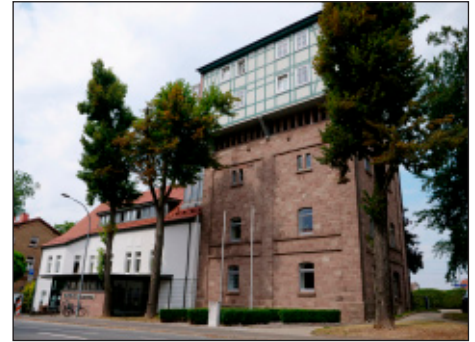
Wasserturm Leinefelde, Bahnhofstraße 43 Bürgerbüro Bauamt Grundstücksverwaltung Personal
