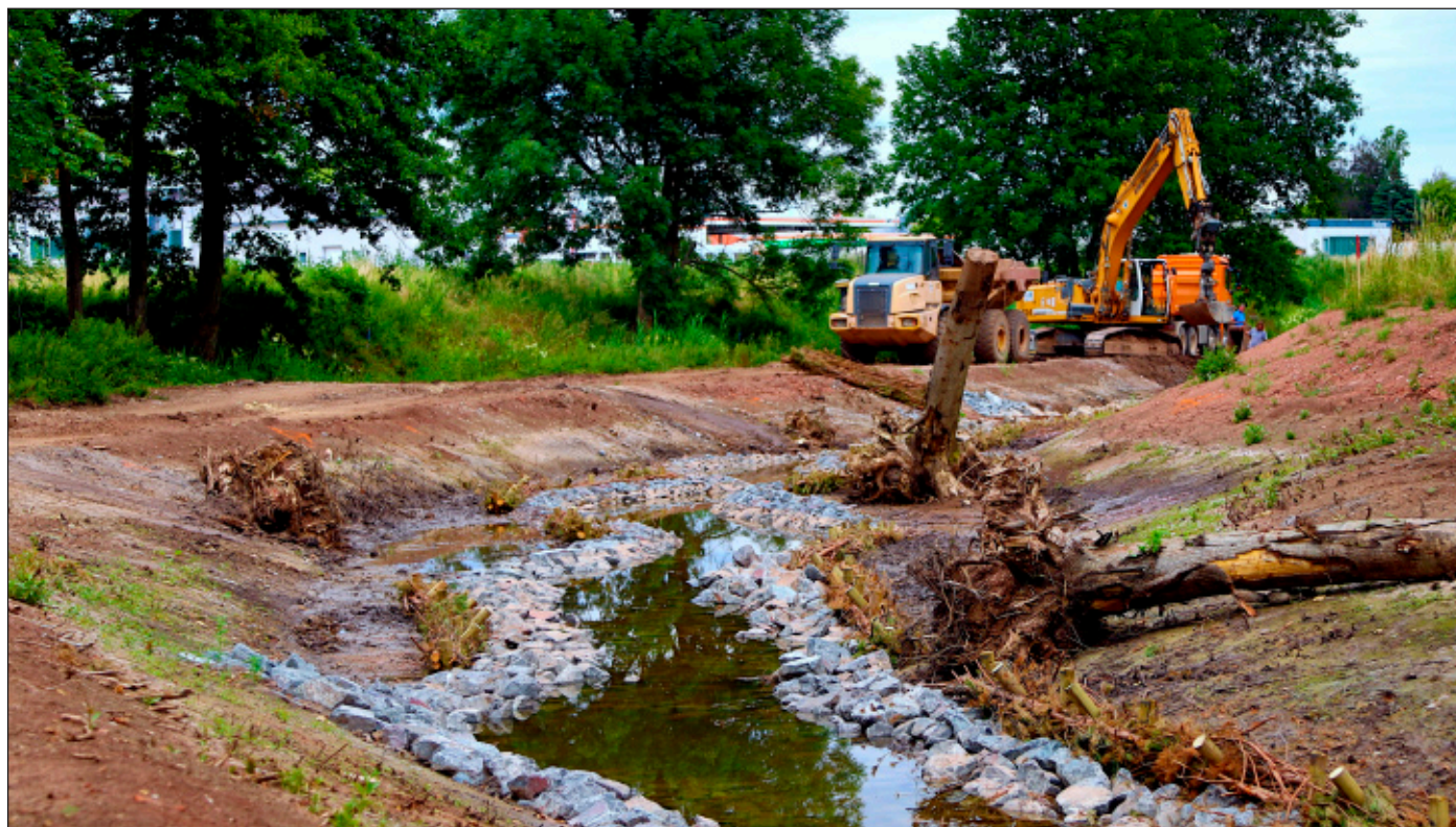
In der Leinefelder Südstadt haben die Umgestaltungen für die Landesgartenschau begonnen. Auf dem Foto ist zu sehen, wie in der Ohne-Aue der alte Bachlauf der Ohne wiederhergestellt wird und sogar schon Wasser führt. Fotos: René Weißbach/Sabina Weber
