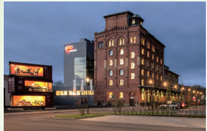
PS.SPEICHER in Einbeck, ©Kulturstiftung Kornhaus
