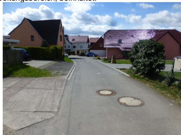
Übergang Bestand zur auszubauenden Straße
