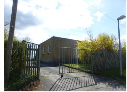
Benachbartes Gebäude als Flachbau, derzeit ohne Nutzung
