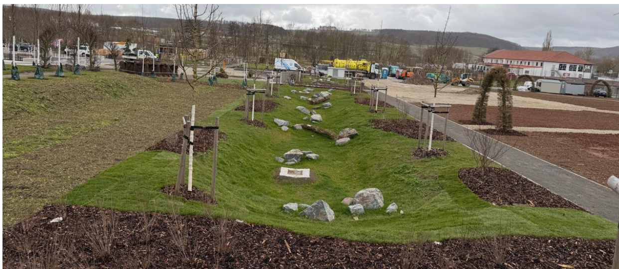
Abbildung 19: Blick auf die Grünflächen zwischen den Baugebieten mit entsprechenden Versickerungsanlagen
