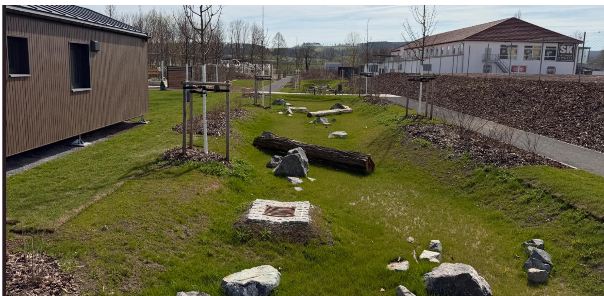
Abbildung 26: Blick auf den in Nord-Süd-Richtung verlaufenden Versickerungsmulden („grüne Finger“)
