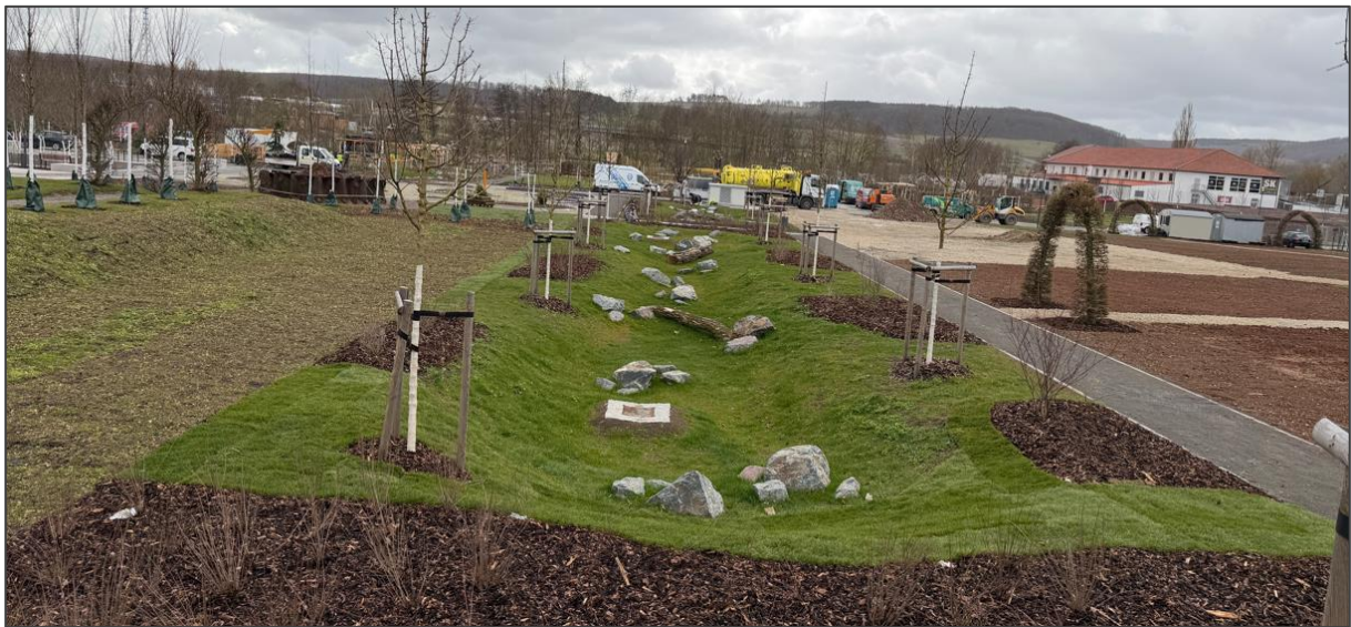
Abbildung 5 fertiggestellte Versickerungsmulde
