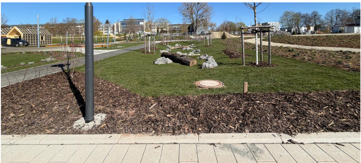
Grüne Finger und Versickerungsanlagen im Bestand
