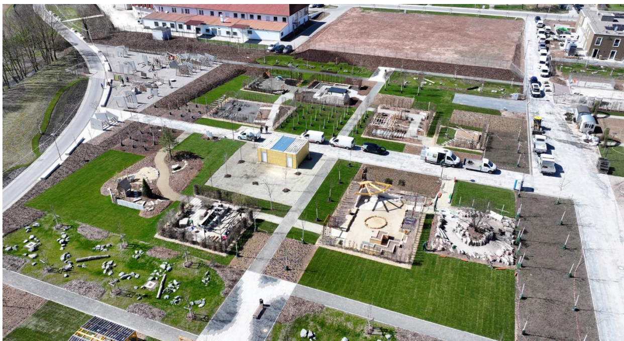
Luftbild der temporären Bauten und Anlagen, die ausschließlich für die LGS2026 errichtet wurden u. einen Rückbau erfordern.
