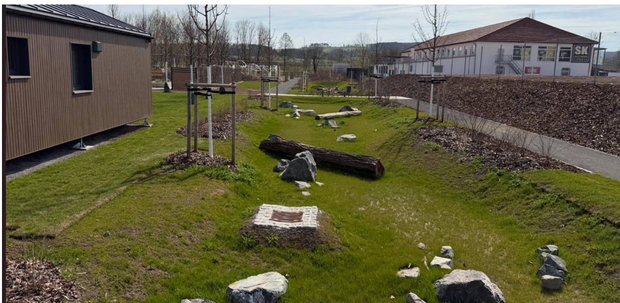
Blick auf den in Nord-Süd-Richtung verlaufenden Versickerungsmulden („grüne Finger“)
