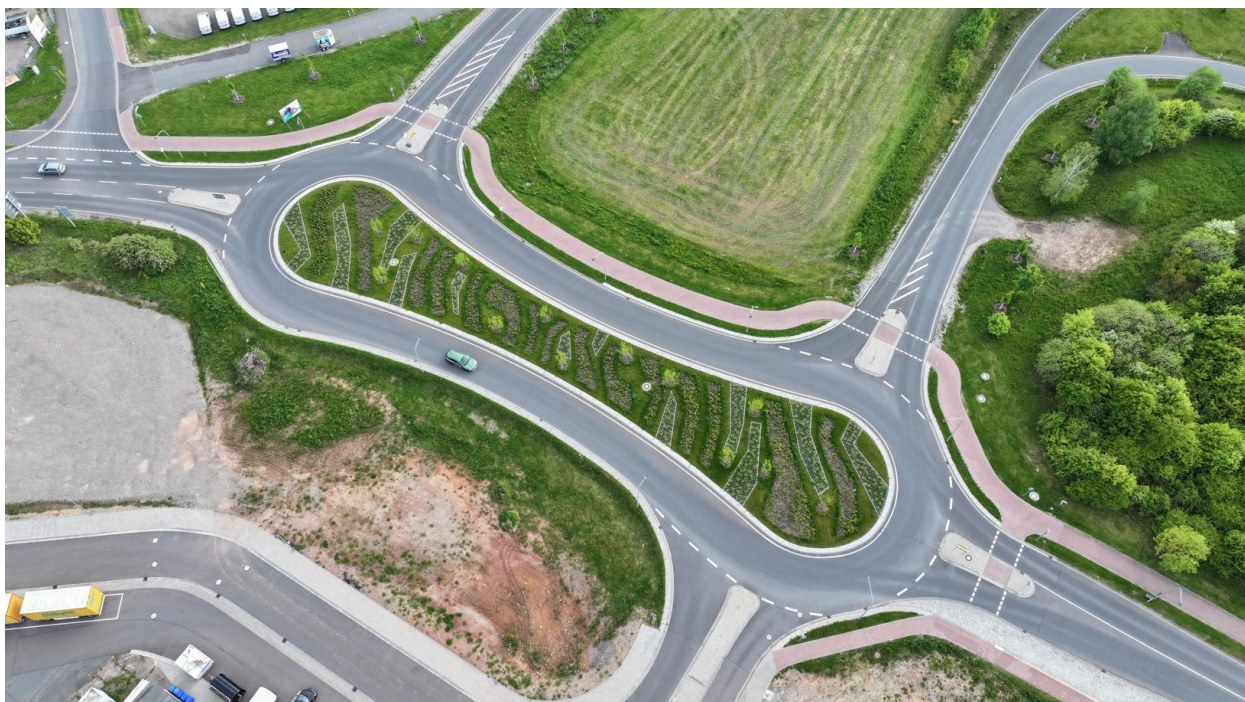
Blick auf den eigens neu erstellten Kreisverkehr (Am Milchhof) zur Verbesserung des Verkehrsflusses in alle Richtungen.
