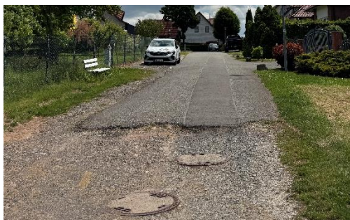
Schächte im Bestand zum vorh. Trennsystem
