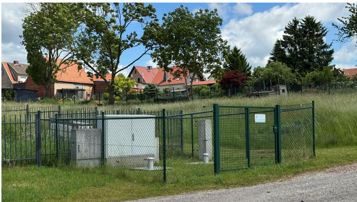
Eingezäunte Pumpanlage der Schmutzwasseranlage mit entsprechender Stromversorgung
