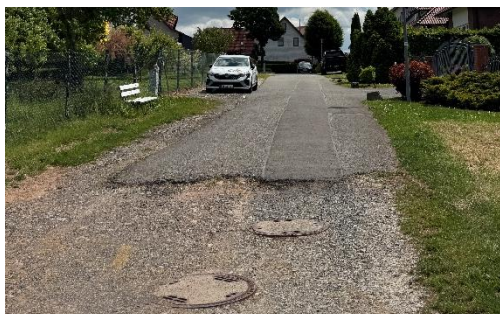
Schächte im Bestand zum vorh. Trennsystem
