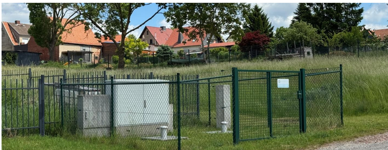
Eingezäunte Pumpanlage der Schmutzwasseranlage mit entsprechender Stromversorgung
