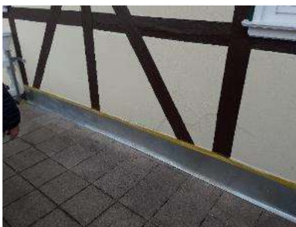
Zinklech im Anschluss von Wand zu Boden
