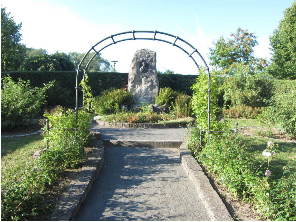
Sanierung Denkmal „Heinrich Werner“
