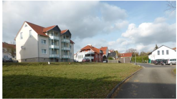
Bebauung in nord-westlicher Richtung
