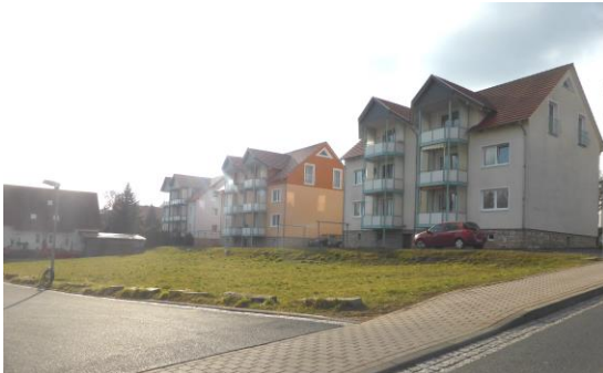
Bestand in südlicher und westlicher Richtung
