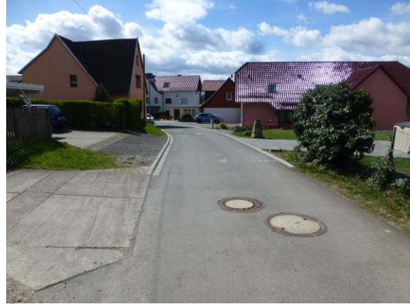
Übergang Bestand zur auszubauenden Straße
