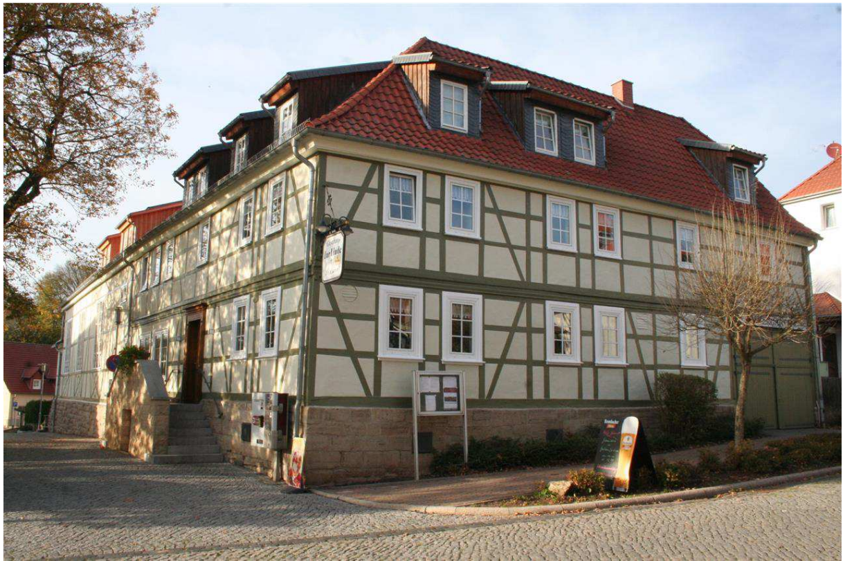
Sanierung Gaststätte „Zur Linde“
