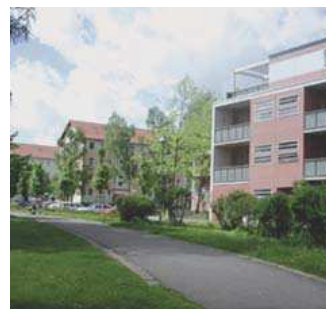
Neue Wohnbebauung am Stadtteich
